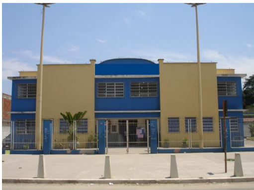
Figura 1 - Visão externa da Escola Municipal.
